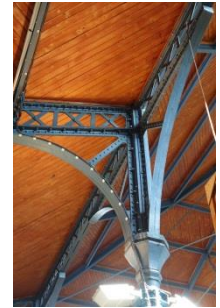
Entraits et arbalétriers
