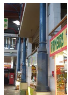
Les colonnes en fonte
